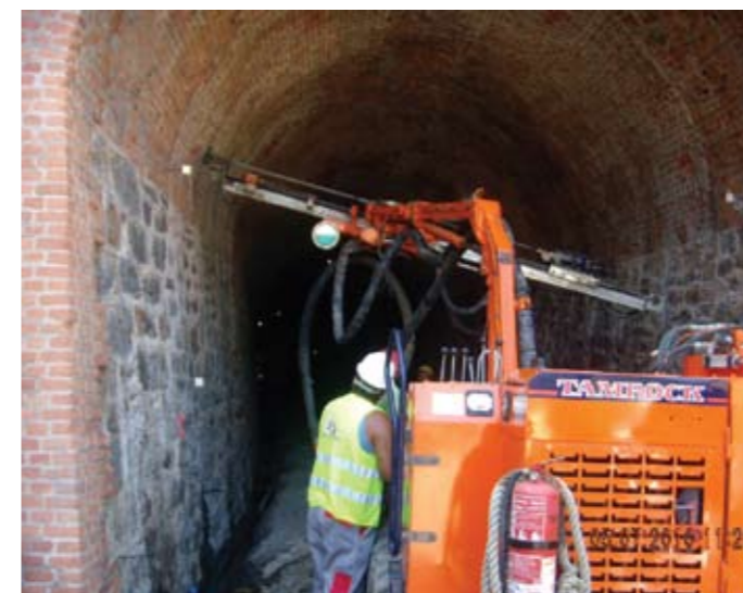
Aspecto da execução de furação em túnel
