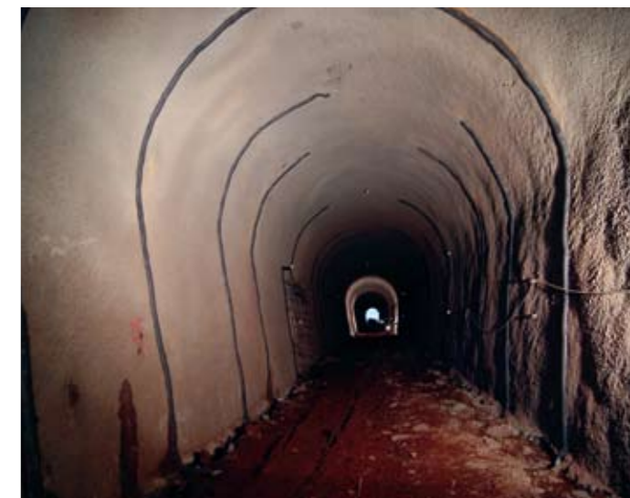
Aspecto de túnel com 1ª camada de betão projectado e drenagem colocada
