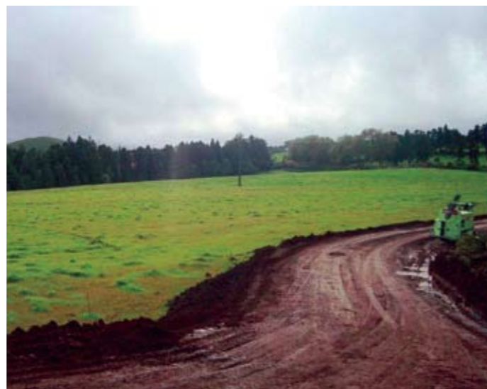
Câmara de empréstimo depois de modelado
