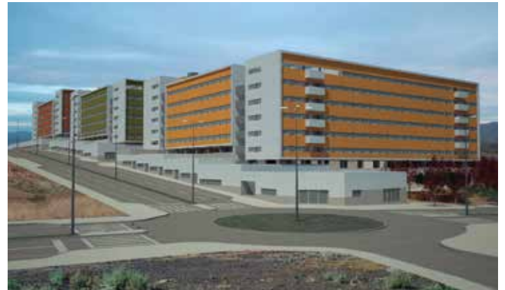
Obra: Construção de 390 habitações de interesse social em Palmarejo Grande, Praia, Ilha de Santiago.
