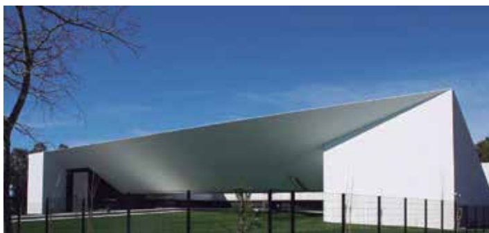
Obra: Escola Superior de Tecnologia e de Gestão – Blocos _ A.B.C Dono de Obra: Instituto Politécnico de Beja
