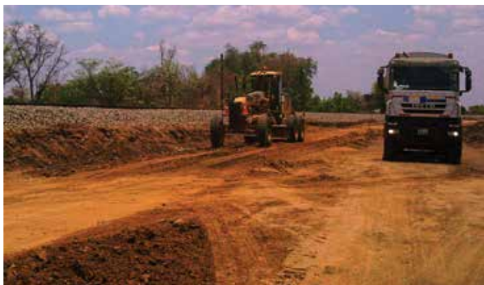
Fig. 4 – Execução de Terraplanagens
