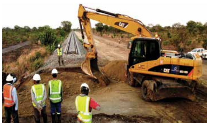
Fig. 7 – Reposição da linha férrea existente
