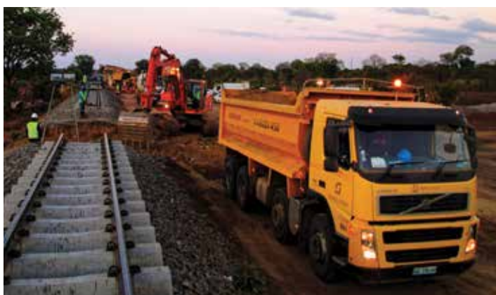
Fig. 6 – Corte da linha férrea existente para materialização da nova drenagem transversal
